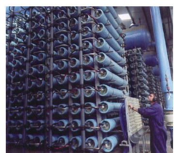
FIG. 7 – Usine de dessalement.
