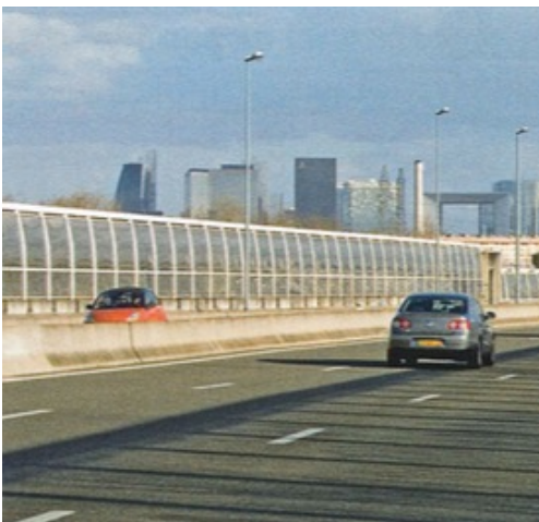
Murs antibruit en polychlorure de vinyle (PVC).
