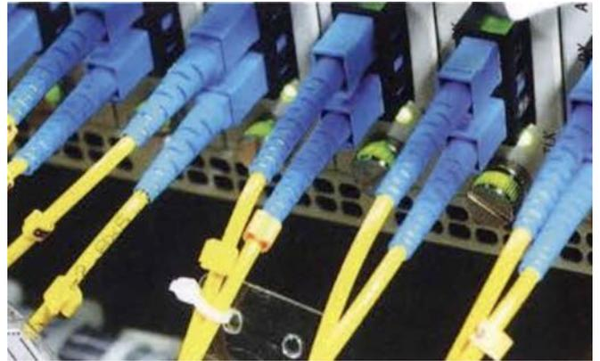
FIG. 12 – Baie de raccordement des fibres optiques. Chaque élément correspond à un abonné.
